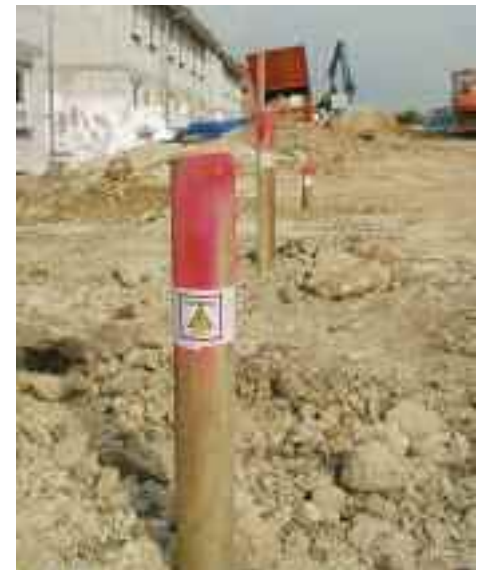
Bild 44 Markierung einer Kabeltrasse
