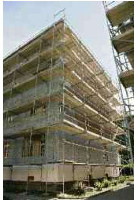
Bild 46 Arbeitsgerüst als Fassadengerüst
