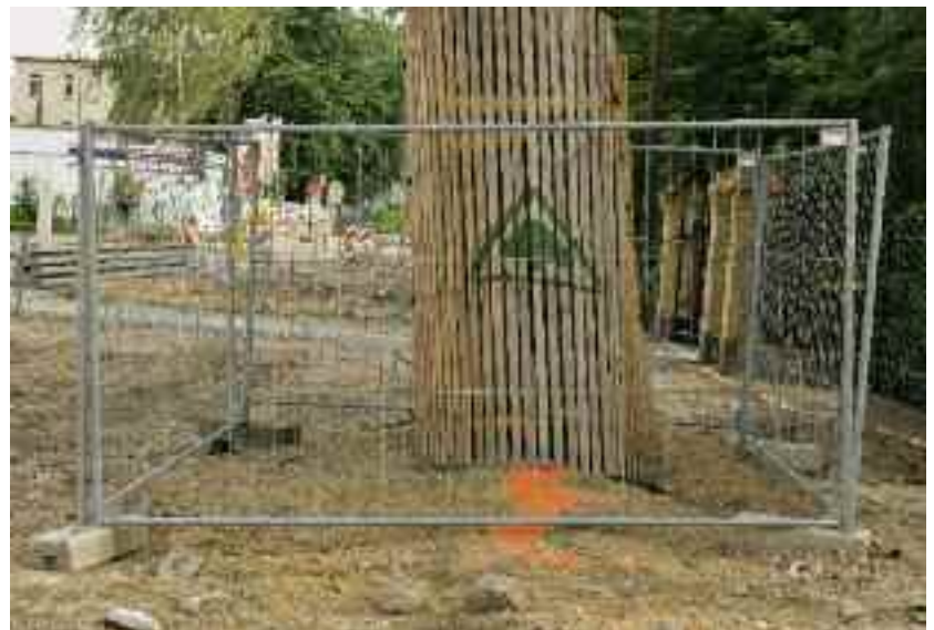
Bild 43 Anfahrtschutz für Baum mit Schutzzaun bei Lagerflächen
