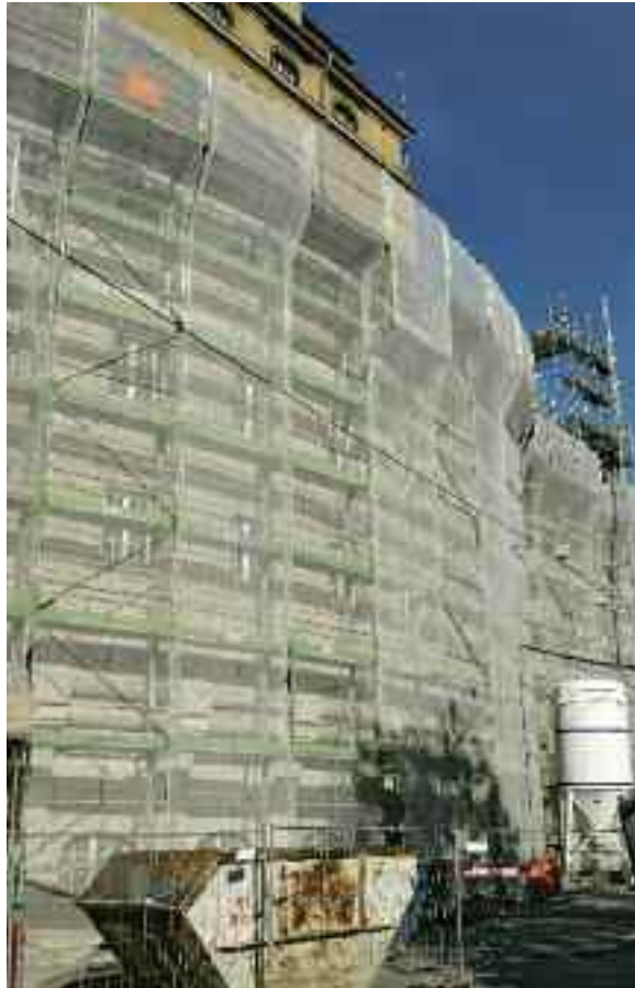
Bild 45 Komplett geschlossenes Gerüst
