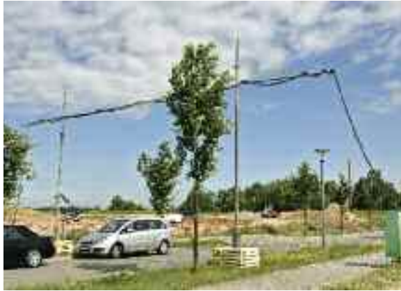
Bild 35 Leitungsbrücke für Leitungsführung
