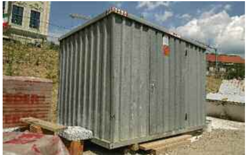
Bild 21 Lagercontainer für Kleingeräte und Kleinmaterial
