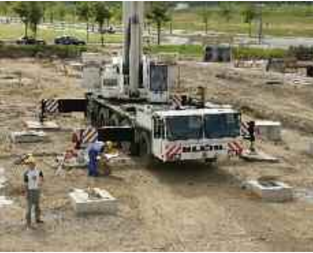
Bild 3 Aufstellung eines Mobildrehkranes, Platzbedarf für notwen- dige Abprätzungen
