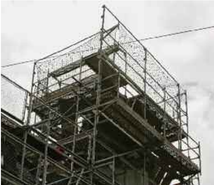
Bild 48 Schutzdach als Fußgängertunnel
