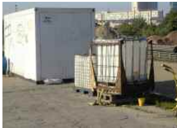
Bild 31 Baustellen-Wasserversorgung für Wasch- und Brauchwasser mittels transportabler Wassertanks
