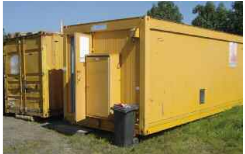
Bild 9 Container als Magazin und als Baustellenbüro mit Pausenraum, Heizung durch Flüssiggas (Gasflaschenschrank)
