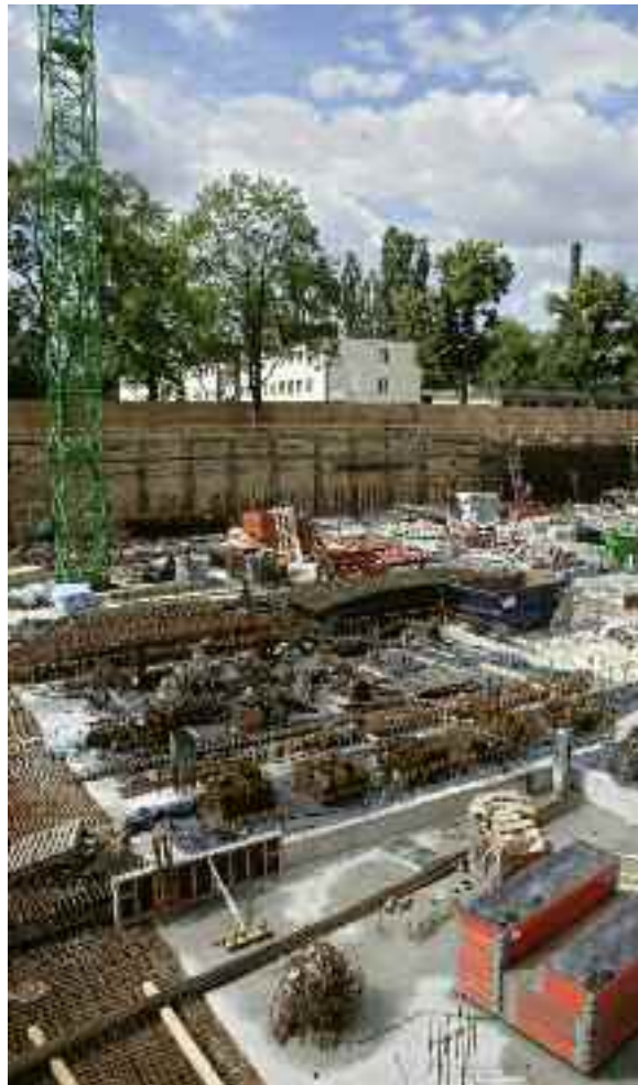
Bild 26 Lagerflächen im Schwenkbereich des Krans
