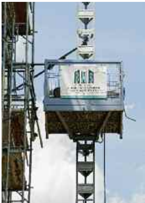
Bild 50 Fassadengerüst mit Lastenaufzug
