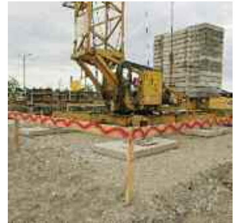
Bild 1 Absperrungen des Schwenkbereiches eines Untendrehers
