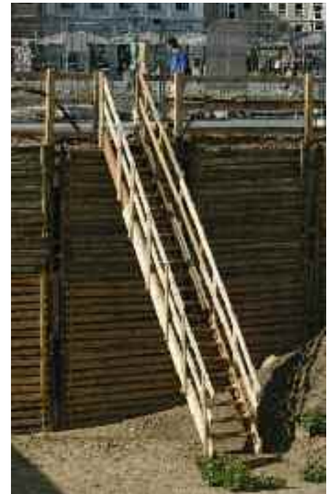
Bild 25 Bautreppe zur siche- ren Erschließung
