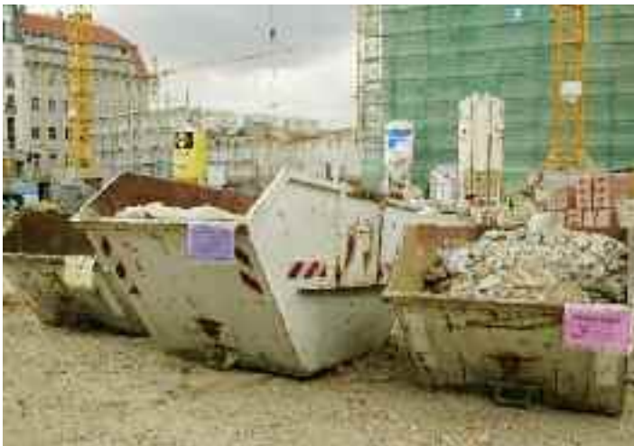
Bild 52 Einsatz von kranbaren Schuttmulden
