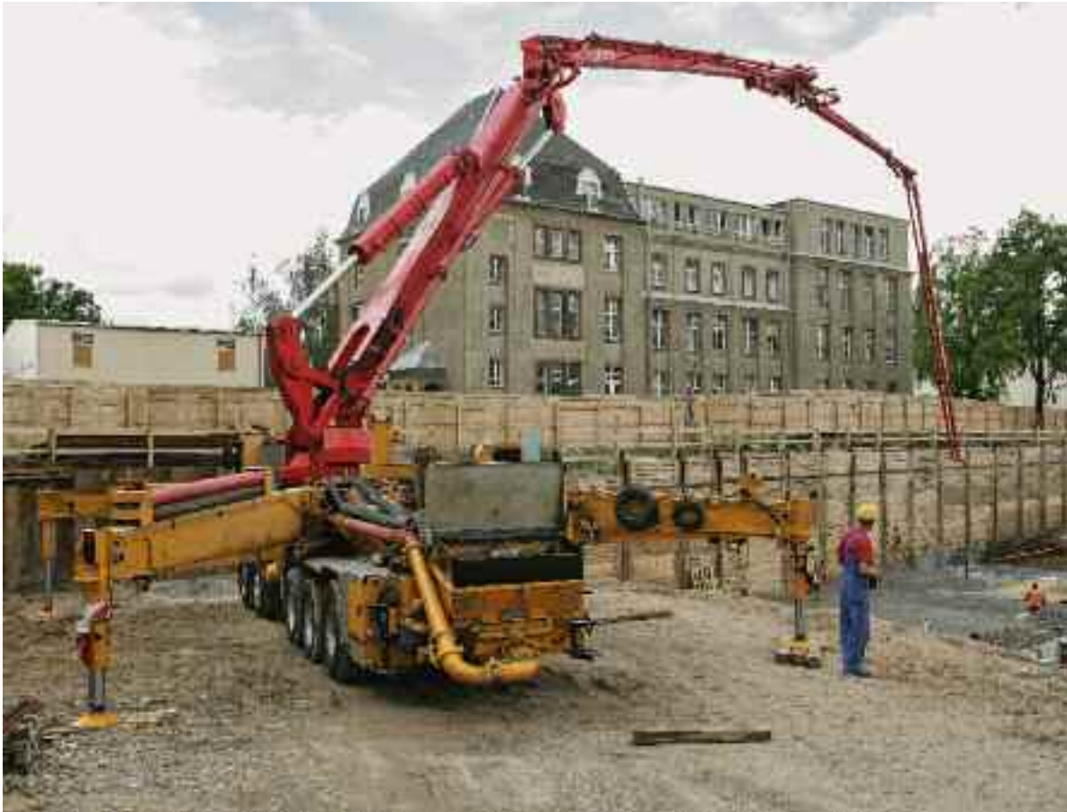
Bild 8 Autobetonpumpe, notwendige Abplatzungen bei Ausfahren des Verteilermastes
