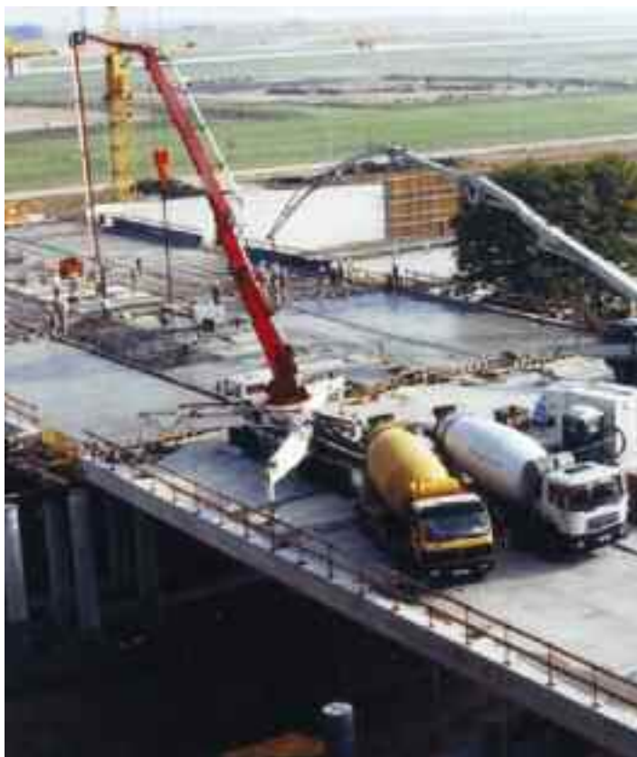
Bild 6 Aufstellfläche einer Autobetonpumpe mit gleichzeitiger Anord- nung zweier Beton- mischfahrzeuge
