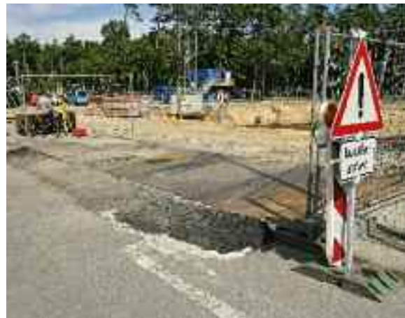
Bild 24 Oberflächenschutz einer Baustellenzufahrt bestehend aus Vlies, Bitumenauflage und Stahlplatten
