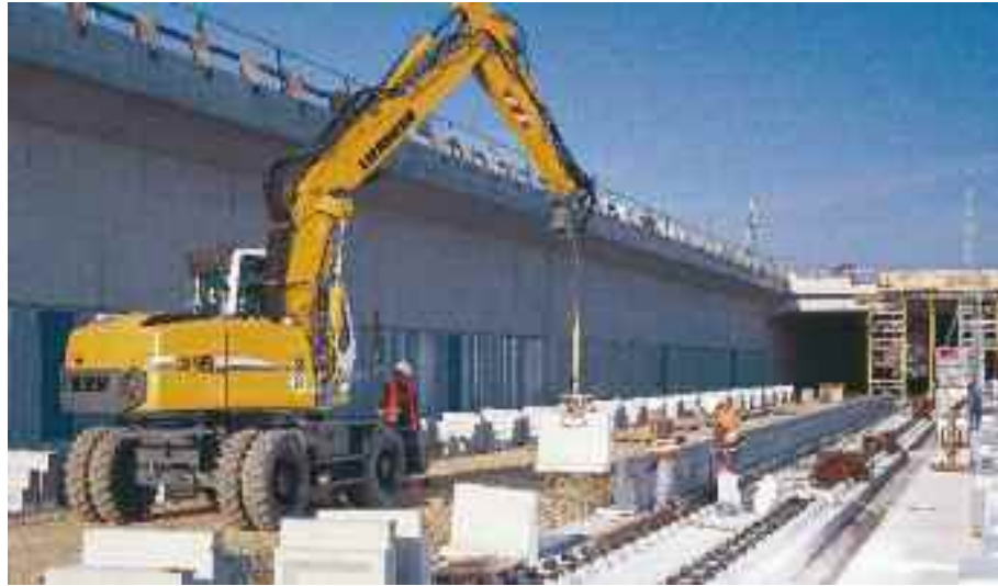
Bild 5 Radbaggereinsatz im kommunalen Tiefbau, kraftbetriebener Transport
