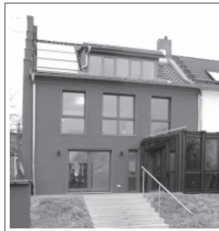
Abb. 1/2: Modernisierung eines Reihenhauses mit Öffnung der Fassade zum Garten [1]
